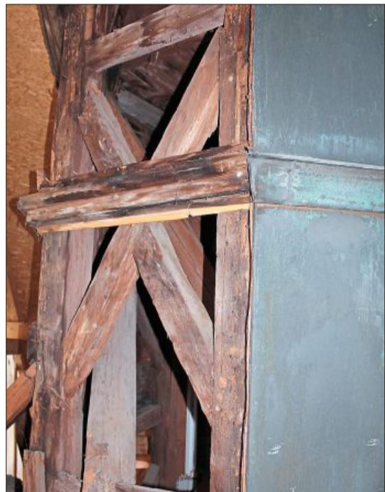
Stahlträger halten den Dachstuhl künftig im Zaum. – Marode Balken mussten teils ersetzt werden. – Und am Glockenturm offenbarten sich unter der Kupfer-Verblechung stärkere Schäden an der Holzkonstruktion als angenommen. Fotos: Monika Schneider-Stranninger
