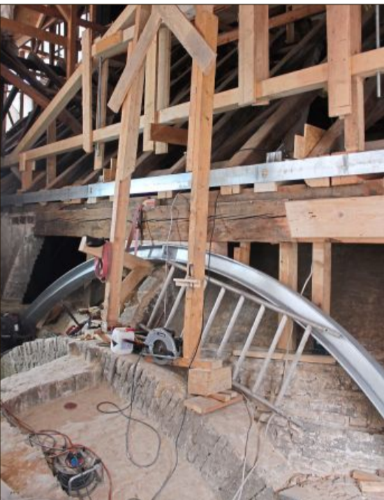
Stahlträger halten den Dachstuhl künftig im Zaum. – Marode Balken mussten teils ersetzt werden. – Und am Glockenturm offenbarten sich unter der Kupfer-Verblechung stärkere Schäden an der Holzkonstruktion als angenommen. Fotos: Monika Schneider-Stranninger
