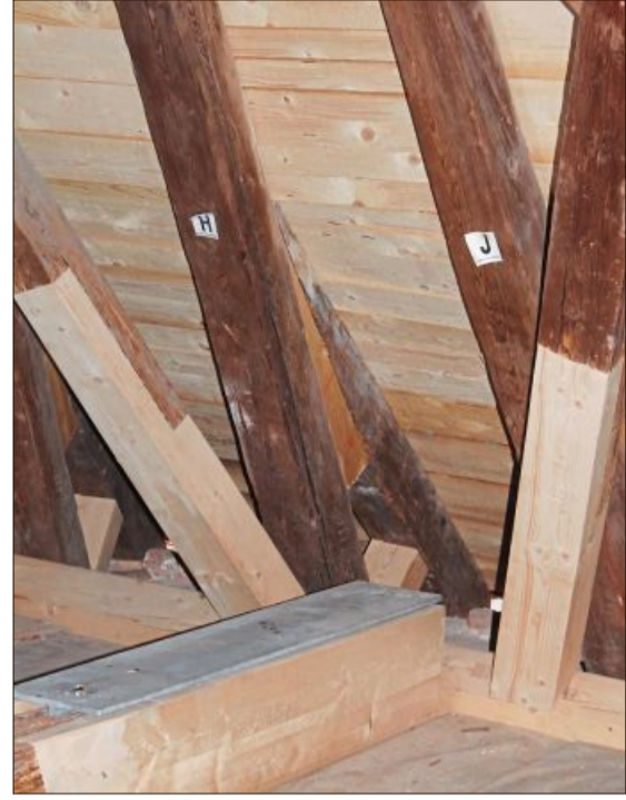
Der Turm der Ursulinenkirche mit Glocke freigelegt. – Die kupfernen Regenrennen mit Rundung. – Ersetzte und ergänzte Balken.
