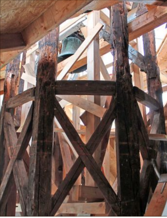
Der Turm der Ursulinenkirche mit Glocke freigelegt. – Die kupfernen Regenrennen mit Rundung. – Ersetzte und ergänzte Balken.
