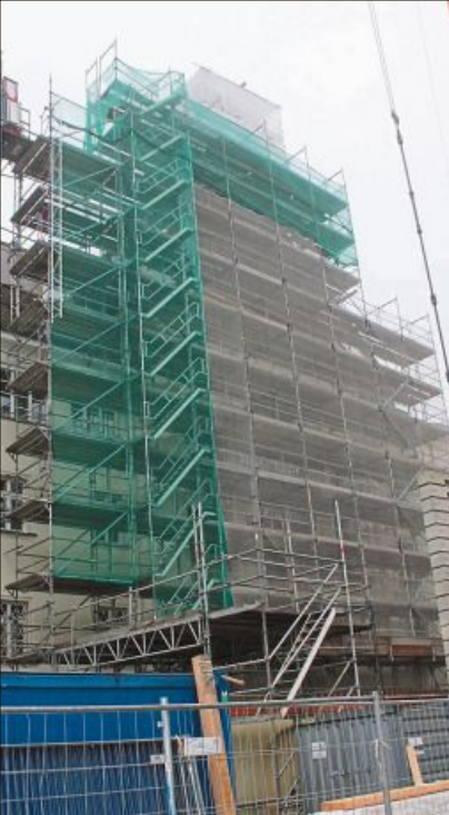
Die eingerüstete Kirchen-Fassade an der Burggasse.
